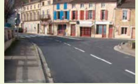
D911F et D673 - Renouvellement de la couche de roulement du carrefour. Ces travaux, financés par le Département à hauteur de 37 500 €, sont réalisés en vue du passage du Tour de France.
