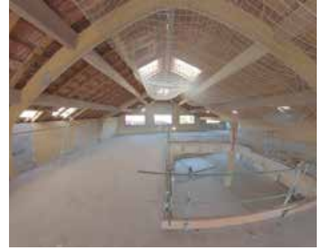
Les travaux de revitalisation de la friche Audevard à Sainte-Livrade ont commencé.
