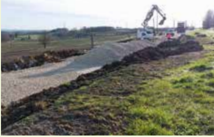
D228 - Travaux d'enrochement de talus et de reconstruction de la chaussée, financés par le Département à hauteur de 280 000 €.
