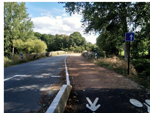
Pont de Vaugon (Saint Armel, 35)
