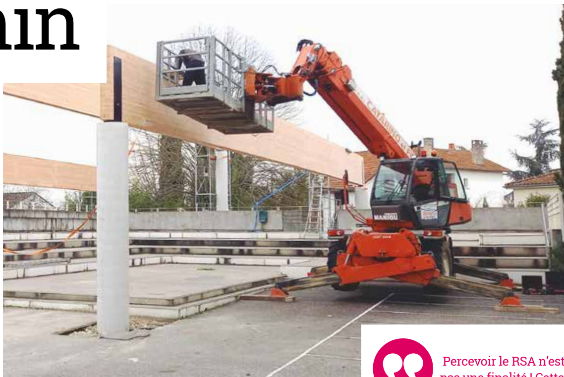
Le chantier du collège Ducos-du-Hauron à Agen bénéficie de clauses d'insertion.
