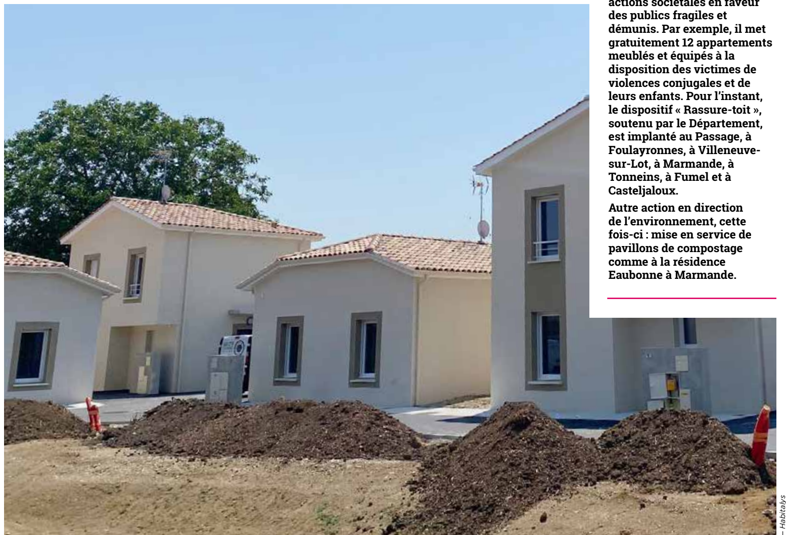
Travaux à la Résidence Simone-Veil à Nérac.
