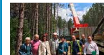
Pindères-Beauziac. Aux côtés des maires et d'Hélène Vidal, levage du pylône de téléphonie installé sous maîtrise d'ouvrage départementale (lire page 7).
