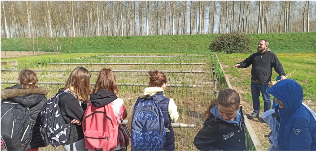
Les bacs de filtration, plantés de roseaux, à l'abri de la digue protégeant des crues de Garonne. Crédit : collège La Rocal ←
