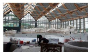
Sur le chantier du Center Parcs.
