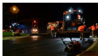
Travaux sur une route du département.
