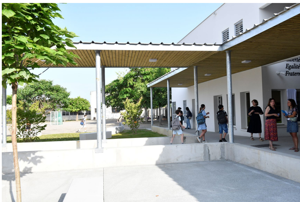
Le collège de Port-Sainte-Marie dont les travaux ont été inaugurés en juin.
