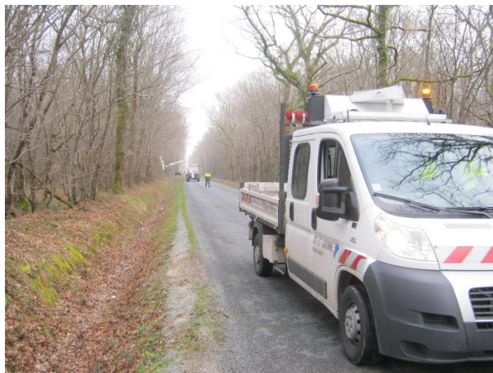
Signalisation d'un chantier mobile
