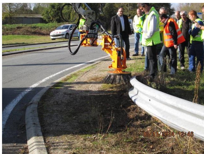
Balayage mécanique sur accotement
