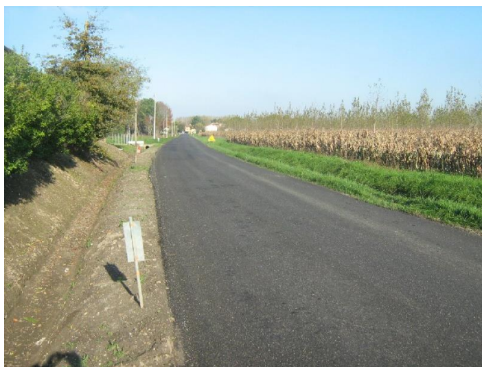
Réfection de chaussée
