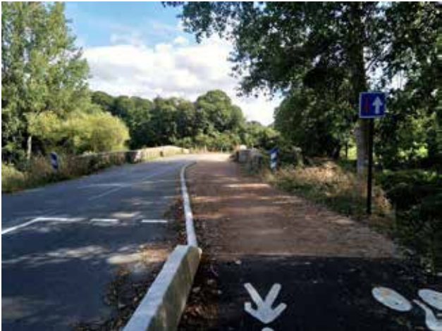
Pont de Vaugon (Saint Armel, 35)
