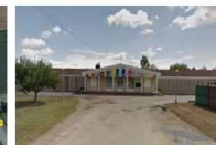
Photo façade avant - Ecole élémentaire
