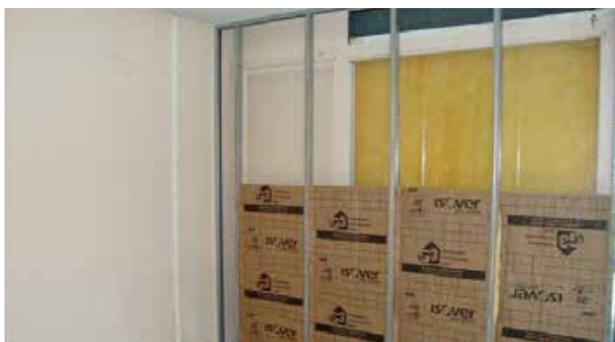
L'amélioration thermique du collège Germillac à Tonneins a été réalisée conjointement par une isolation thermique intérieure et extérieure
