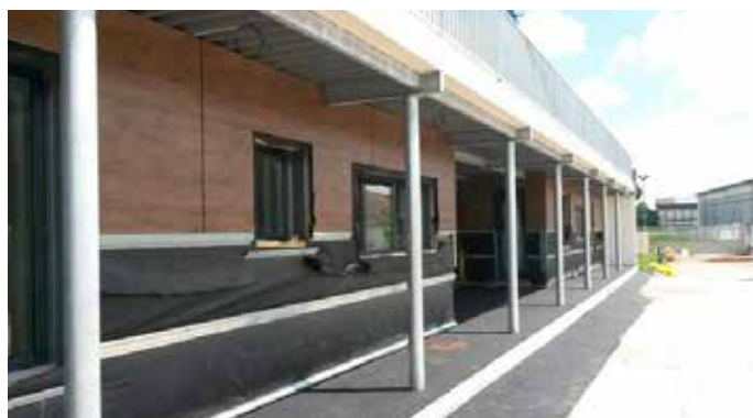
L'amélioration thermique du collège Germillac à Tonneins a été réalisée conjointement par une isolation thermique intérieure et extérieure
