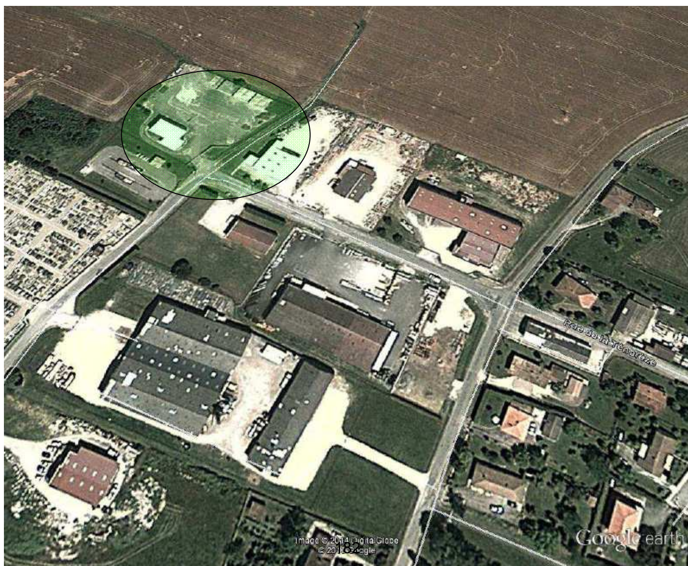
Vue aérienne de l'ancien point d'appui départemental de Mézin
