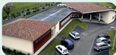
Maison de la vie associative, Villeneuve-sur-Lot
