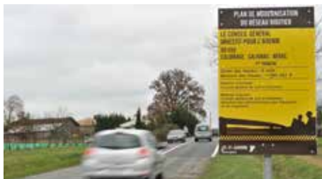
Désenclavement de l'Albret - Travaux sur la D 656 entre Nérac et Calignac
