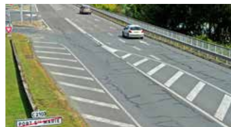
Route départementale entre Fourtic et Port-Ste-Marie en attente d'un nouvel enrobé.
