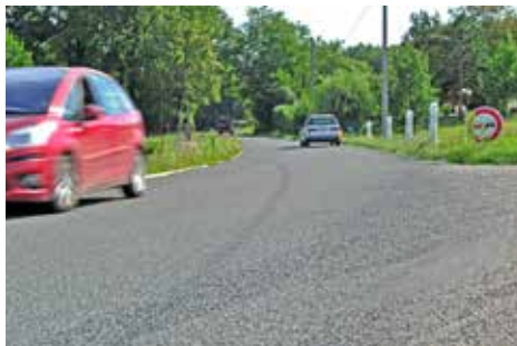
D233. Enrobé réalisé. Prochaine étape : le marquage au sol (Villeneuve-sur-Lot / Penne d'Agenais).
