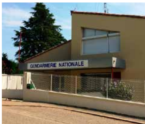
La caserne de gendarmerie de Prayssas a fait l'objet d'un important programme de rénovation dans le cadre du bail conclu entre le Département et Batimur/Vinci.
